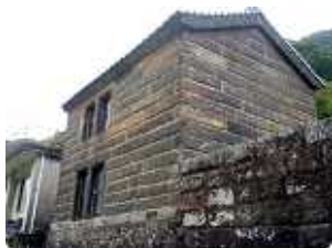
日之影 石造倉庫
